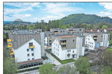
Durch die Aufstockung wurden 24 neue Wohnungen geschaffen. | Beigestellt |
