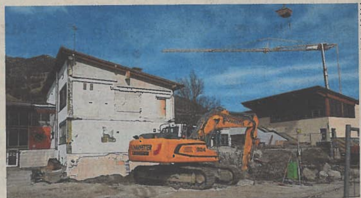
Schon im Herbst soll im neuen Zubau unterrichtet werden
