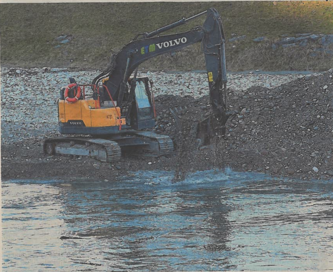
Ab heute sind im Bereich des Müllner Steges wieder Bagger für die Salzburg AG im Einsatz
