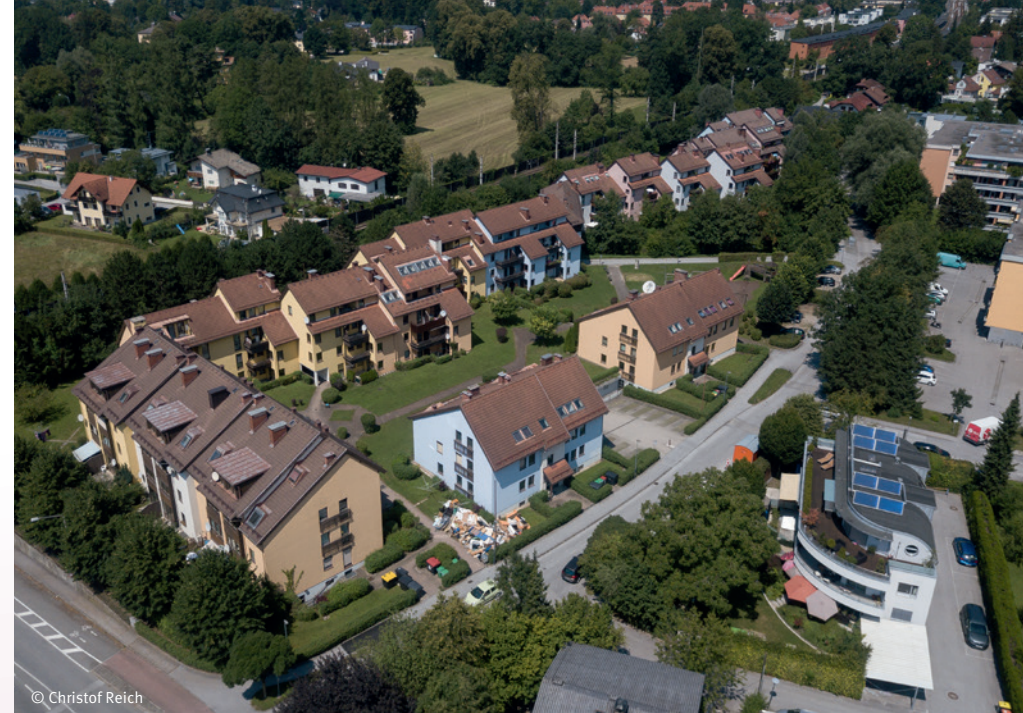
Die Siedlung in der Friedrich-Inhauser-Straße vor Beginn der Sanierungsmaßnahmen.
